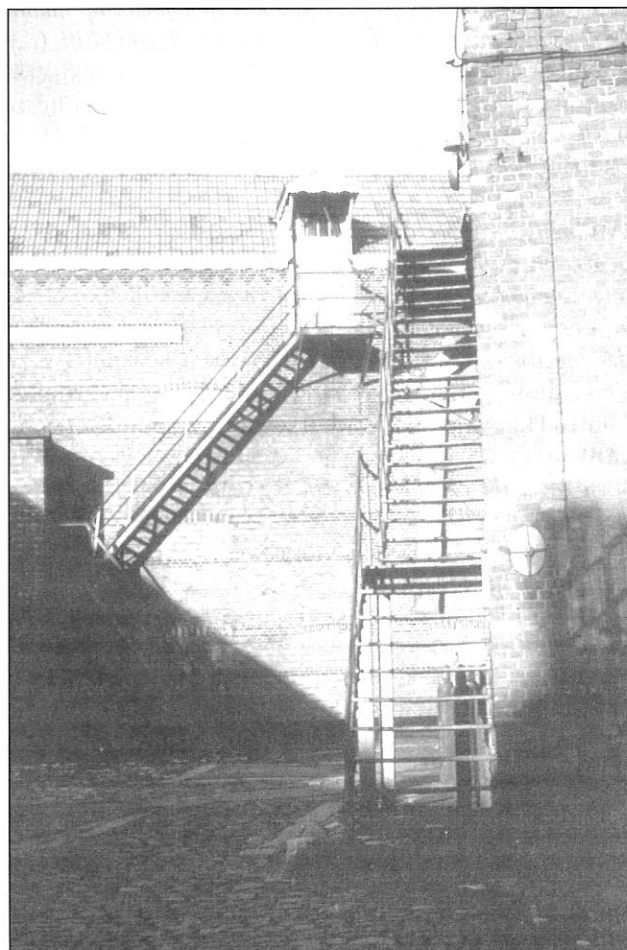
Brouwerij Beirens te Wommelgem. Achter de metalen trap die naar de brouwzaal leidt, is de drafgoot zichtbaar. (Dia P. Bakeroot, 1969)
